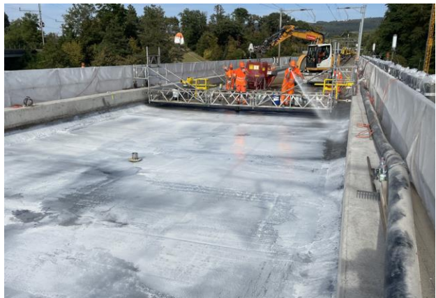
Abbildungen 21, 22, 23, 24: SU Landstrasse (oben links) und Viadukt Fislisbach (oben rechts) (Fotos: SBB). Einbau des Frisch-UHFB (unten links) auf dem Betonschottertrug des Viadukts Fislisbach und umgehende Applikation einer Wachsschicht als Nachbehandlung (unten rechts) (Fotos: KIBAG Sommer 2023).
