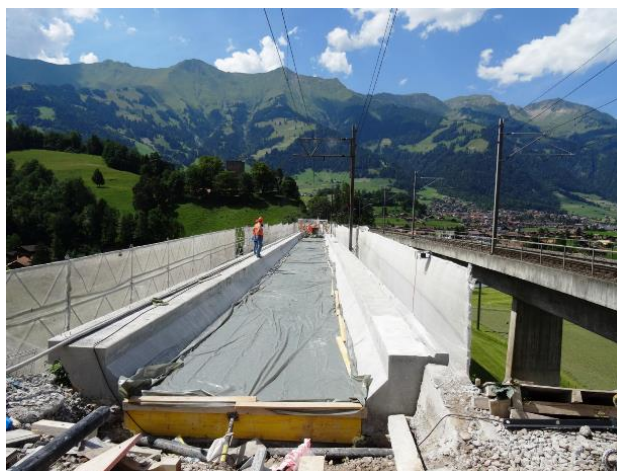
Abbildungen 17, 18, 19, 20: Eingerüstetes Mauerwerksviadukt (oben links). UHFB-Auskleidung des Betontrögs: UHFB-Einbau auf seitlicher Aufbahrung (geschalt) und Dienststeg (oben rechts); auf dem Tragboden (unten links) und Gesamtsicht nach Abschluss des Einbaus (unten rechts) (Fotos: E. Brühwiler 05.07.2017).
