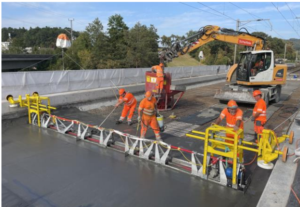
Abbildungen 21, 22, 23, 24: SU Landstrasse (oben links) und Viadukt Fislisbach (oben rechts) (Fotos: SBB). Einbau des Frisch-UHFB (unten links) auf dem Betonschottertrug des Viadukts Fislisbach und umgehende Applikation einer Wachsschicht als Nachbehandlung (unten rechts) (Fotos: KIBAG Sommer 2023).
