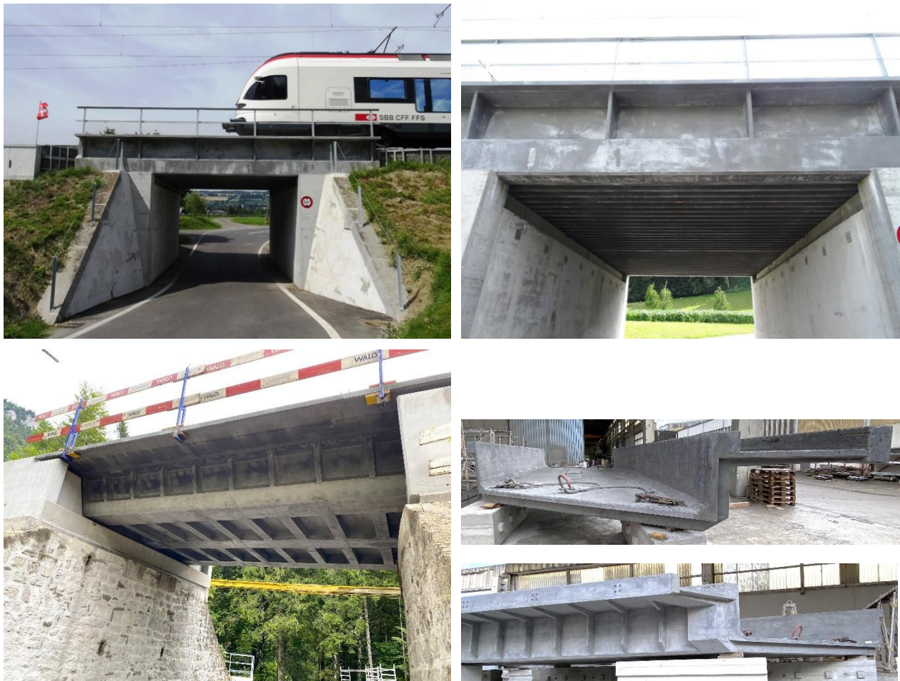
Abbildungen 13, 14, 15, 16: oben: SSB SU Unterwalden bei Sempach (Foto: E. Brühwiler 26.06.2018) mit einer Spannweite von 6,0 m; unten links: Travys Aiguillon-Bahnbrücke in Baulmes (Foto: E. Brühwiler 14.07.2021) mit einer Spannweite von 6,0 m; unten rechts: 9 m langes, in einem Guss gefertigtes Trog-Fertigteil im Werk für die MGB Bahnhofbrücke in Gluringen (Foto: E. Brühwiler 10.10.2024).
