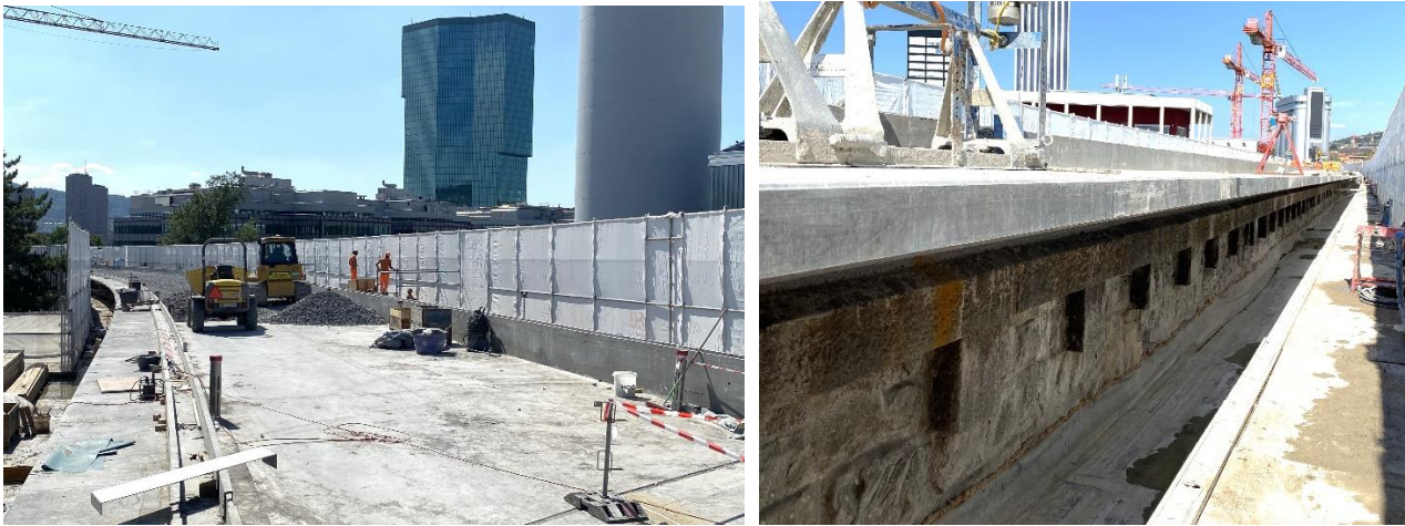
Abbildungen 9 und 10: links: mit UHFBS ausgekleideter neuer (breiterer) Schottertrog auf dem Mauerwerksviadukt; rechts: auskragende UHFBS-Platte über der originalen Mauerwerkskrone (Fotos: E. Brühwiler 15.08.2024).
