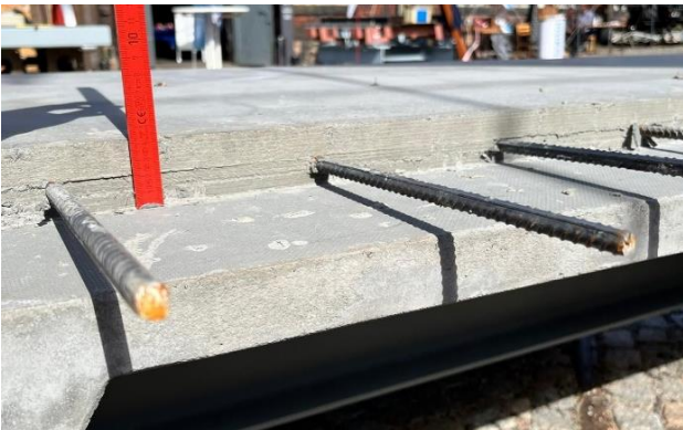
Abbildungen 32, 33, 34: oben links: Betonage im Fertigteilwerk, der spätere Schottertrug ist dabei senkrecht aufgestellt. Oben rechts und unten links: Detail der Anschlussfuge, die mit UHFV vergossen wird. Unten rechts: Ausstellung des Musterbauteils bei den Chemnitzer Eisenbahntagen 2024 (Fotos: oben links: M. Großkopff, oben und unten rechts: M. Falk, unten links: C. Pelka, 2024).
