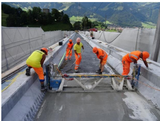
Abbildungen 17, 18, 19, 20: Eingerüstetes Mauerwerksviadukt (oben links). UHFB-Auskleidung des Betontrögs: UHFB-Einbau auf seitlicher Aufbahrung (geschalt) und Dienststeg (oben rechts); auf dem Tragboden (unten links) und Gesamtsicht nach Abschluss des Einbaus (unten rechts) (Fotos: E. Brühwiler 05.07.2017).
