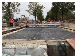
Multifunktionales Verstärkungs- und Schutzsystem aus textilbewehrtem Hochleistungsmörtel für Brückenbauwerke (SMART-Deck) /7, 8/
