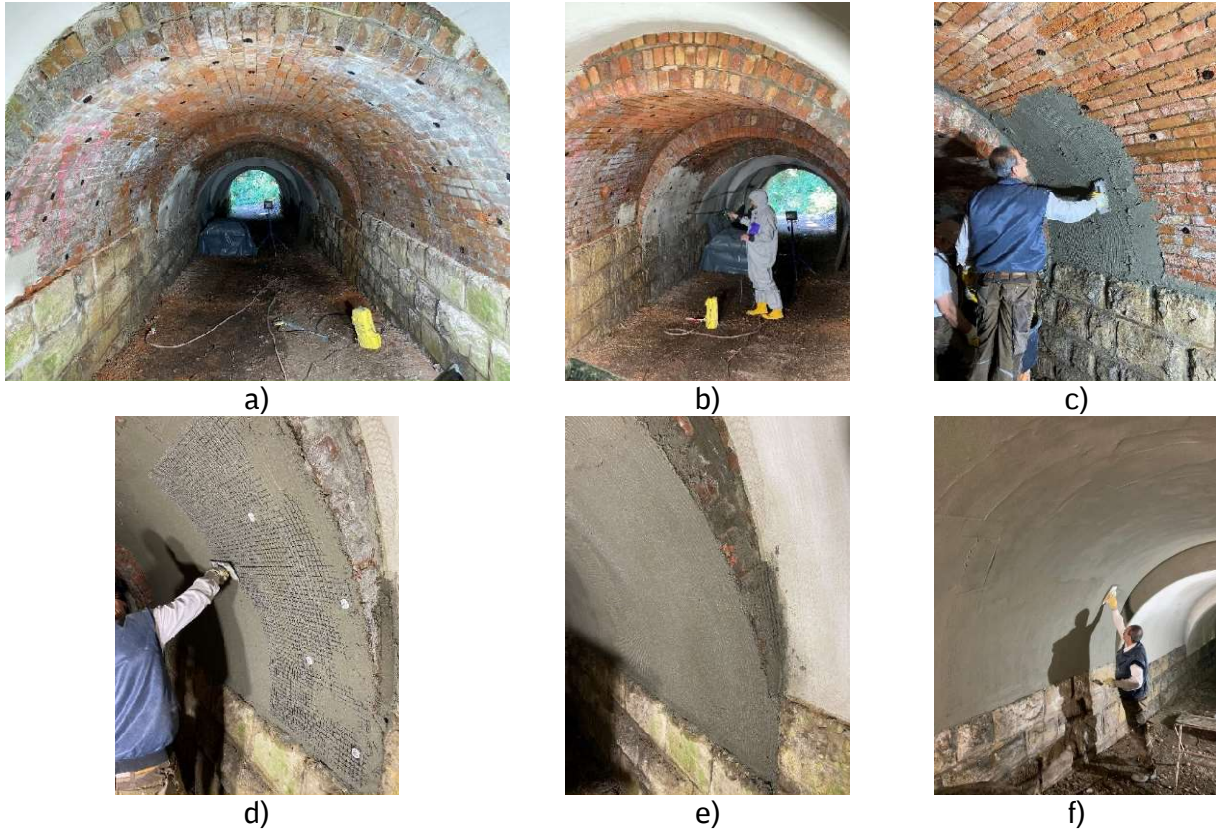
Abbildung 14: Exemplarische Darstellung einzelner Applikationsschritte: a) Setzen der Dübelhülsen, b) Reinigung und Vornässen des Untergrunds mittels Hochdruckreiniger, c) Vorlegen der ersten Mörtellage bis auf Höhe der Abstandshalter, d) Verputzen der textilen Bewehrung mit der Zahnkeller, e) Erste Mörtellage, f) Auftrag der zweiten Mörtellage nach 14-tägiger Aushärtungszeit /11/
