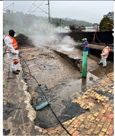
Abbildung 11: Kevag Viadukt – Reinigung des Untergrundes mittels Hochdruckwasserstrahlen
