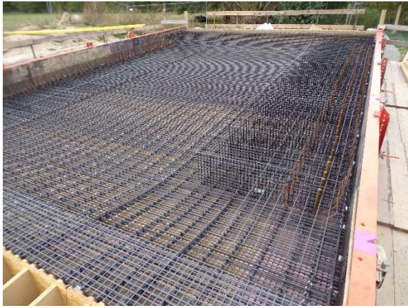
Überbau - untere Bewehrungslage
