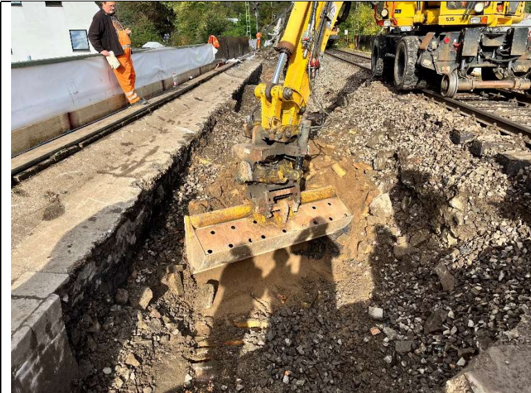
Abbildung 10: Kevag Viadukt – Rückbau Gleise und Ausbau Bestandsschotter
