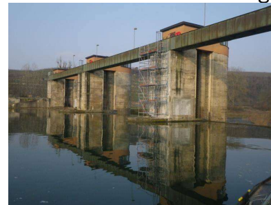
Instandsetzung des Wehr Horkheim als dauerhafter Schutz der Bauwerks Oberfläche mit gleichzeitiger Rissüberbrückungsfähigkeit /13, 14/
