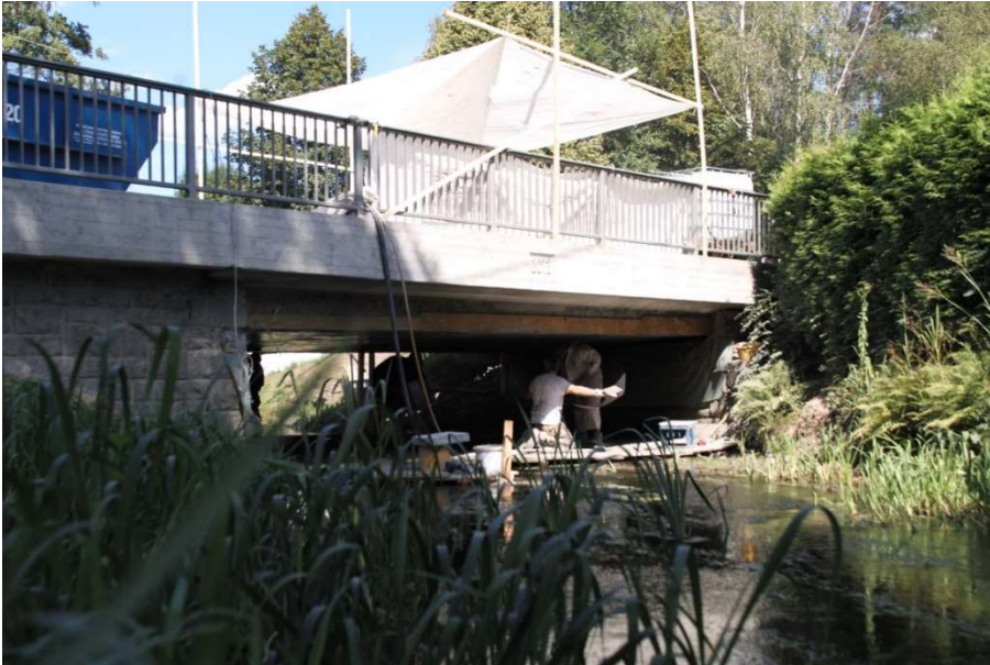
Abbildung 7: Ansicht der Plattenbrücke während der Verstärkungsarbeiten mit Carbonbeton
