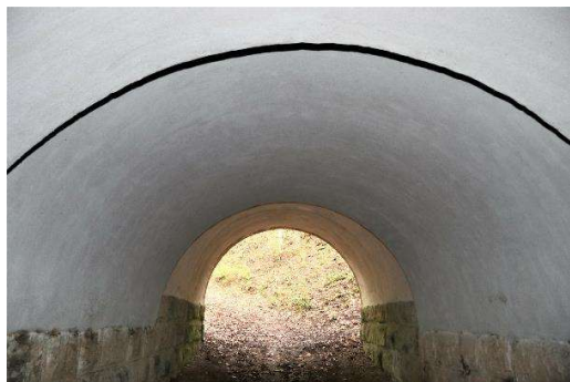
Mörtelbasiertes, textilbewehrtes Abdichtungssystem für gemauerte Gewölbebrücken /11/
