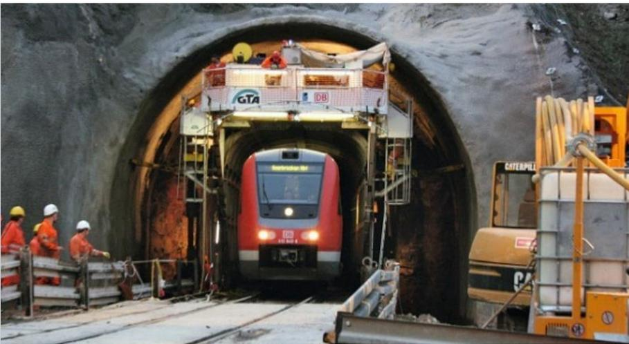
Bau unter rollendem Rad: Ein Tunnelvortriebsportal trennt den Zugverkehr von den Bauarbeiten.
