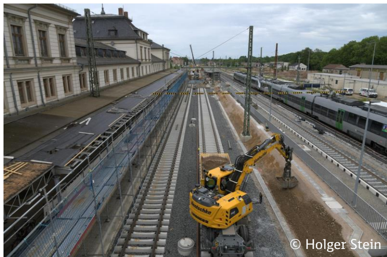
Abb. 3 Bahnsteig 4 und Einkürzen Dach Hausbahnsteig
