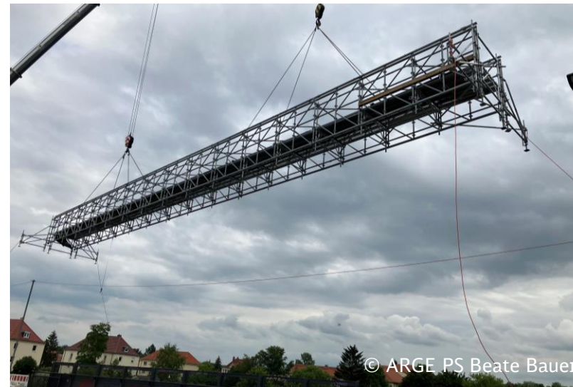
Abb. 2 Einbau Kabelhilfsbrücke neben SÜ Koburger Straße
