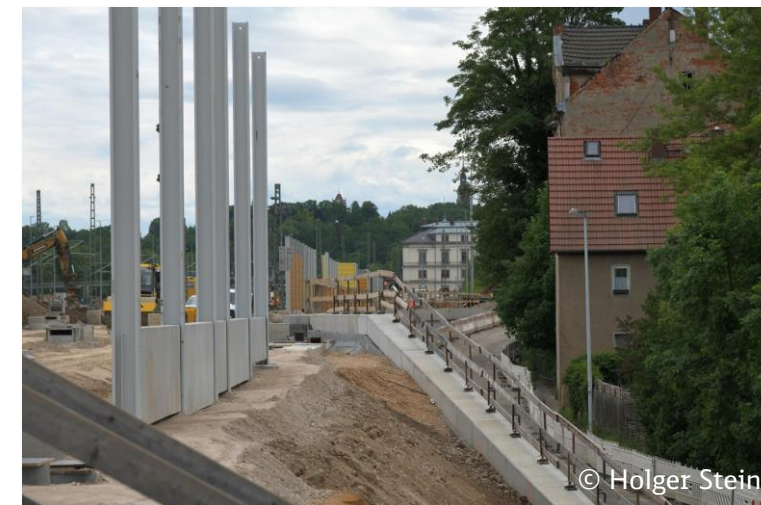
Abb. 5 Aufbau LSW 3 und Stützwand 7 – Kopfbalken
