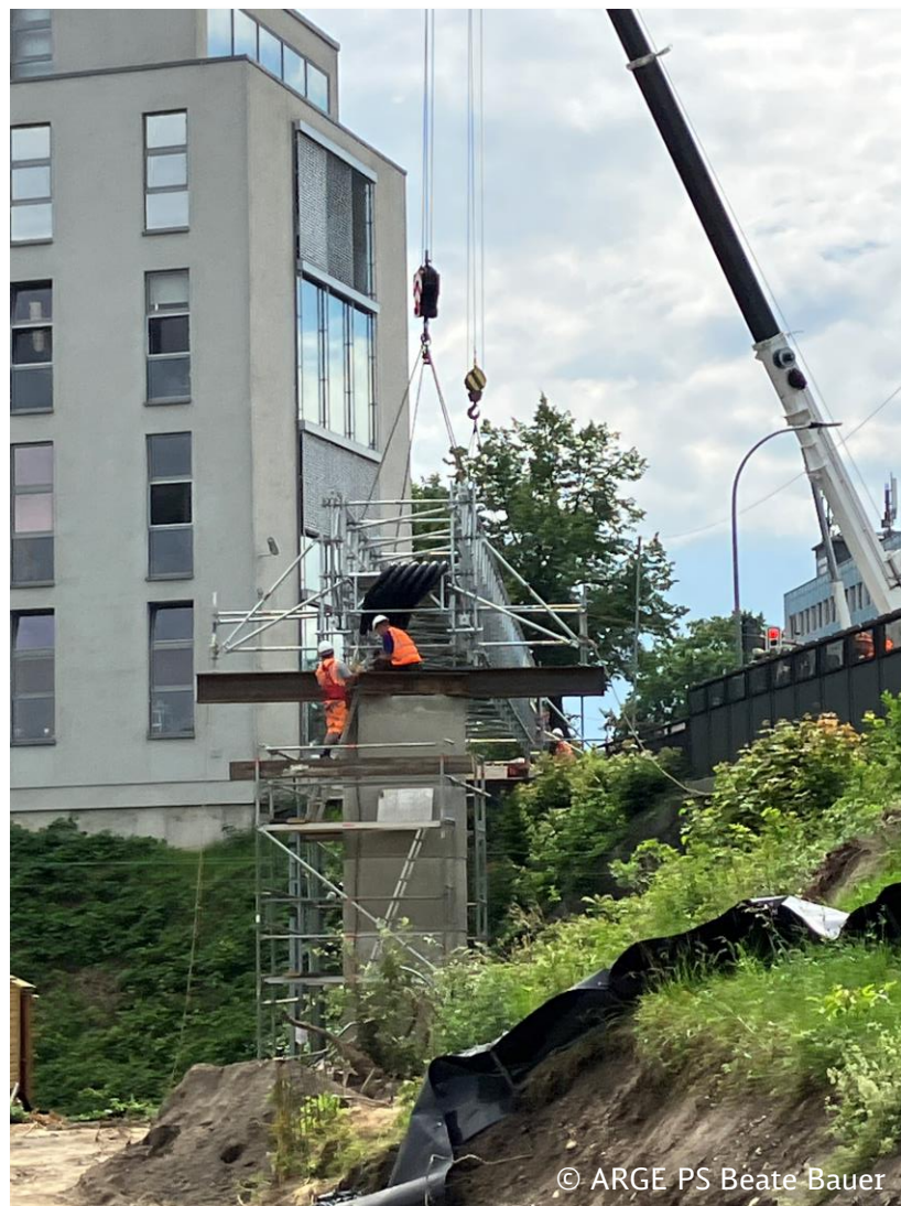
Abb. 3 Aufbau Kabelhilfsbrücke
