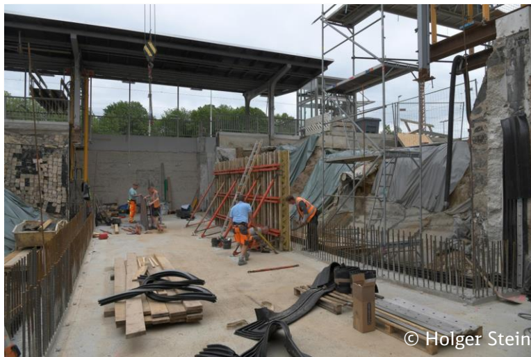
Abb. 1 EÜ km 38,575 Personenunterführung – Schalung Wände
